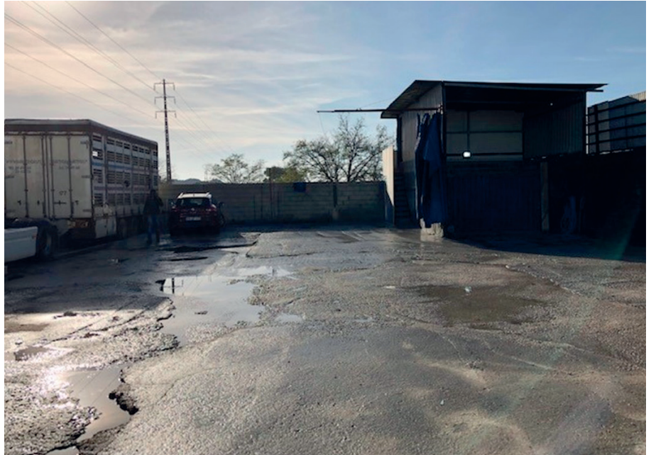
Figura 8. El paviment del centre ha d'estar en bon estat per evitar la presència de basals. Autor: Anna Romagosa.
