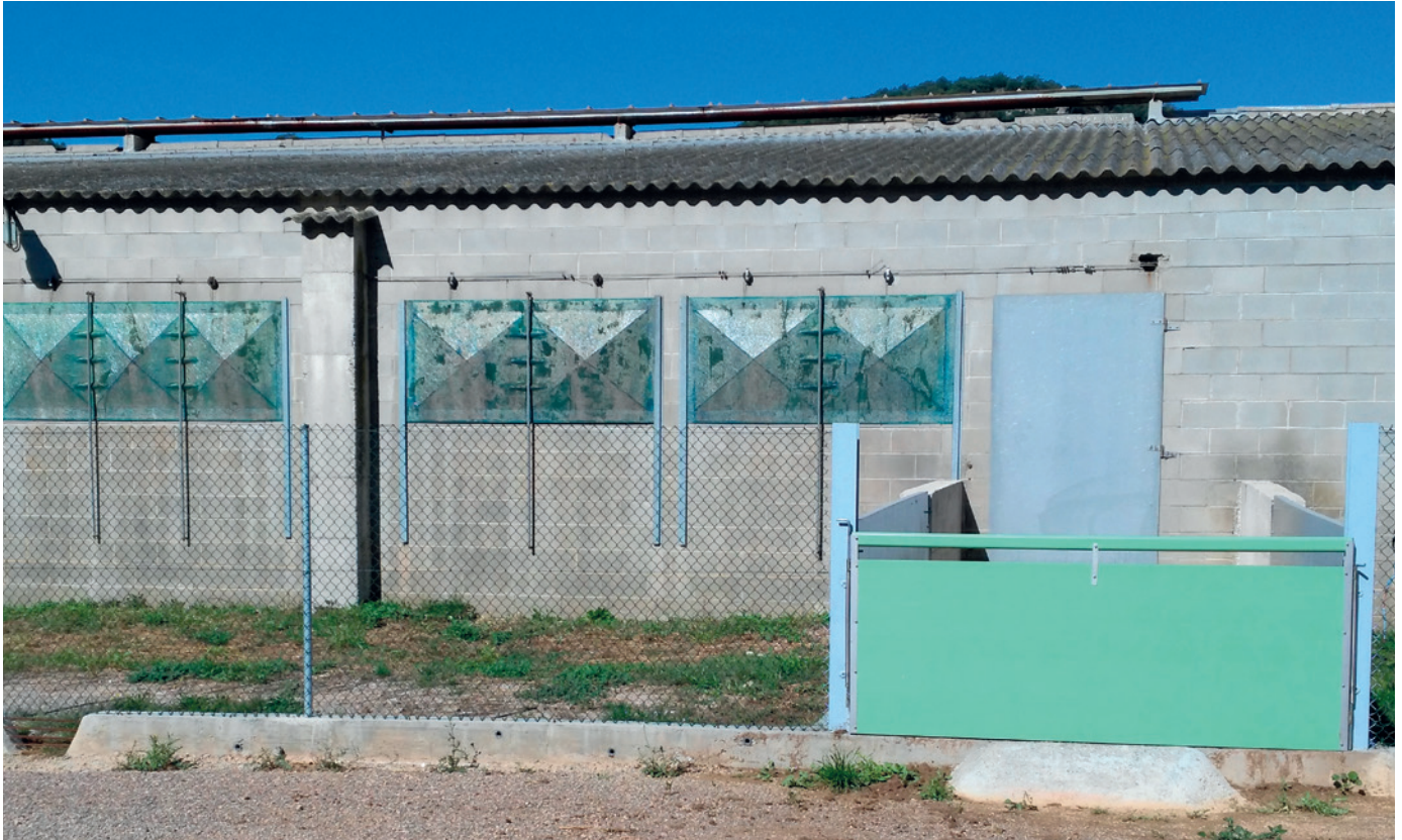
Figura 6. Tanca perimetral i moll de càrrega. Autor: Gumersindo Villa Rodríguez
