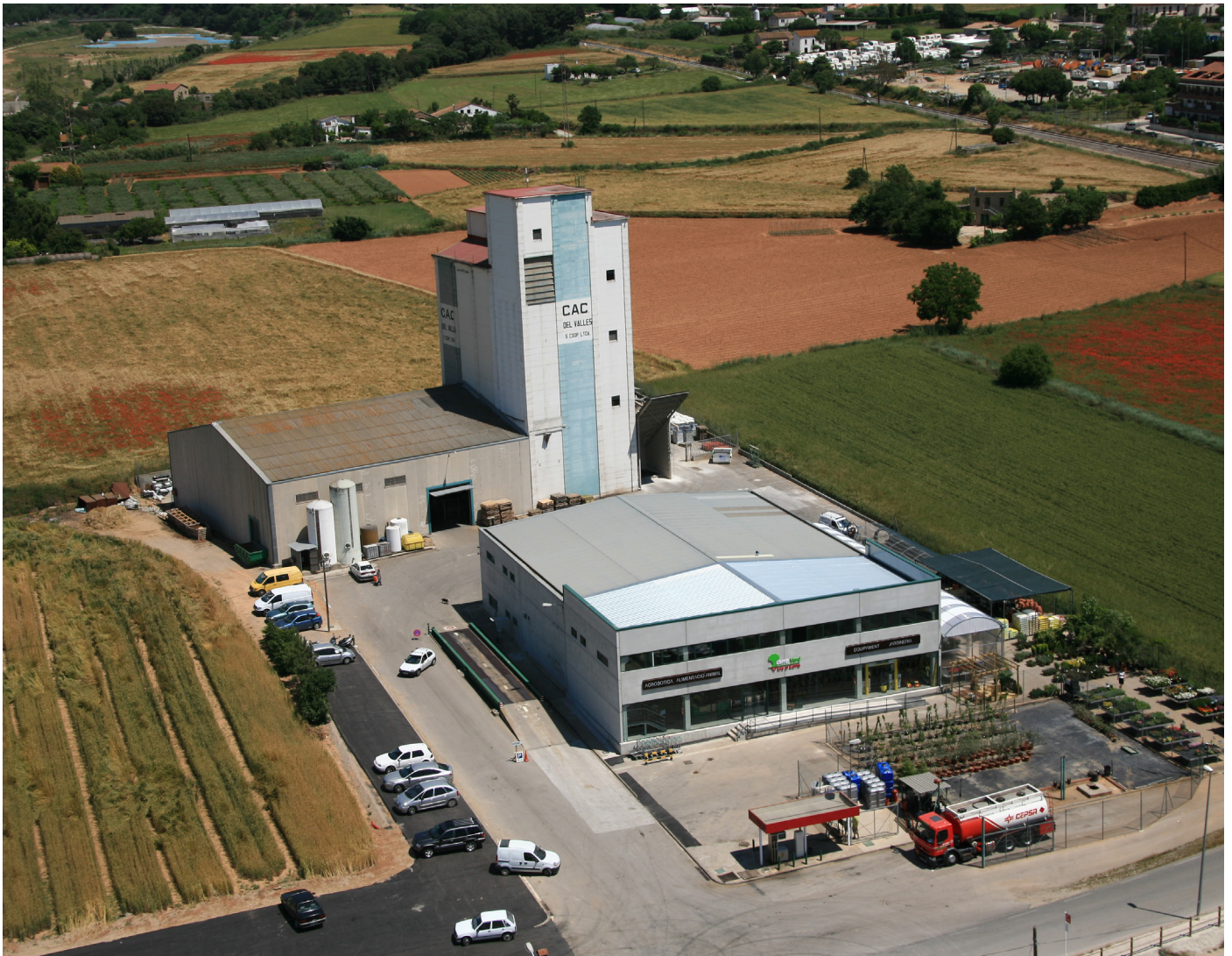
Instalaciones de la Cooperativa Agraria Comarcal de El Vallès. Foto: Agrària del Vallès SCCL.
