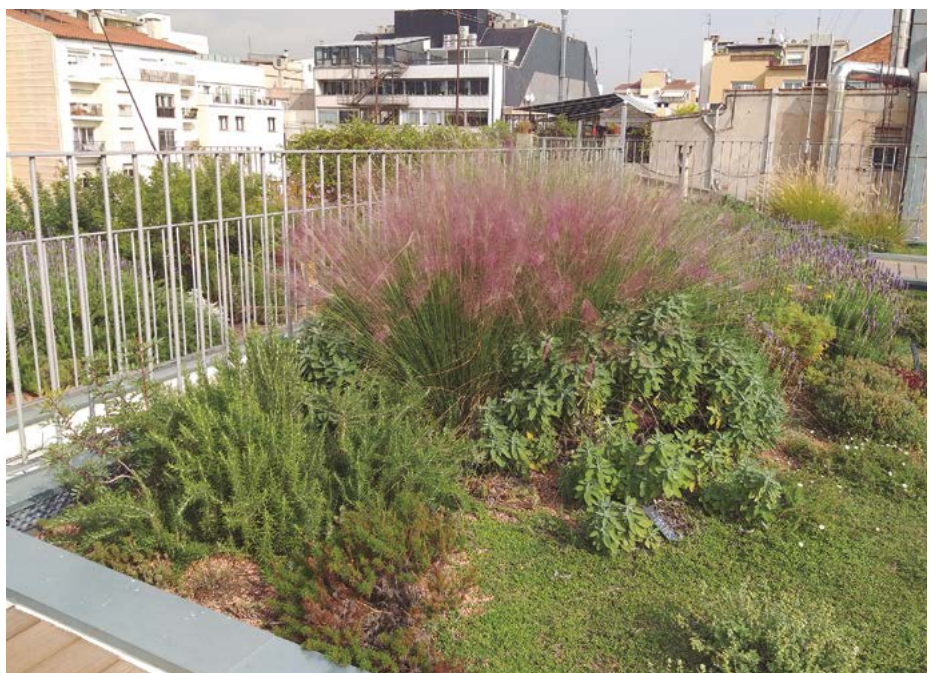
Coberta enjardinada semiextensiva Escola Pérez-Iborra de BCN. Foto: IT4S Research Group.
