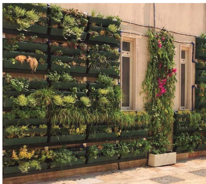
Jardí vertical de tractament d'aigües grises en una escola primària a Ferla (Itàlia). Foto: IRIDRA, Itàlia.
