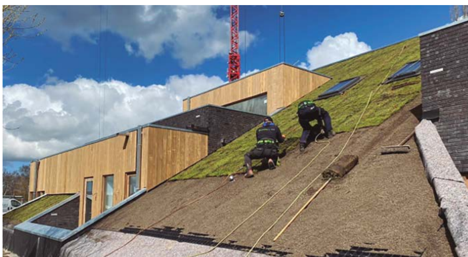
Solució verda instantània en una coberta inclinada. Foto: Sempergreen.
