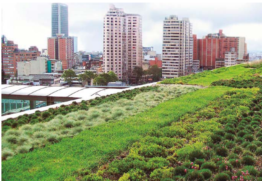
Coberta verda extensiva. Foto: ZinCo Cubiertas Ecológicas.
