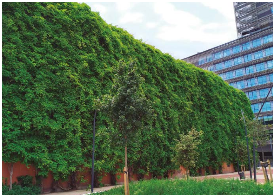
Façana verda. Edifici Districlima, Barcelona 2021. Foto: Guillem Lacoma
