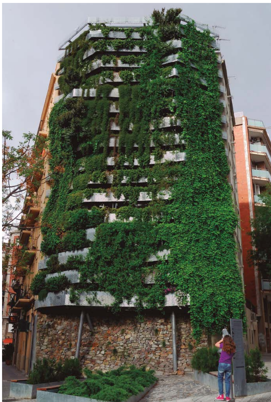
Jardí Tarradellas, exemple pioner de jardí vertical aplicat a manteniment municipal mitjançant contenidors suspesos. Foto: www.babilon.cat .
