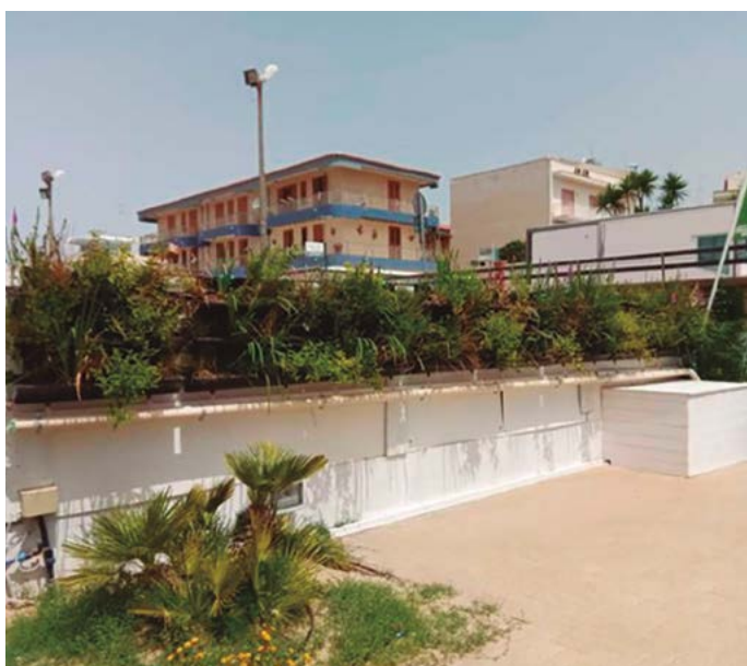
Jardí vertical que tracta aigües grises a Marina di Ragusa, Sicília (Itàlia) Foto: IRIDRA, Itàlia.
