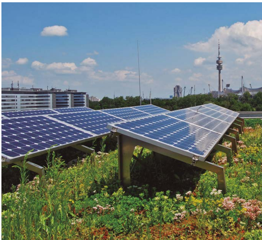
Coberta verda biosolar. Foto: ZinCo Cubiertas Ecológicas.
