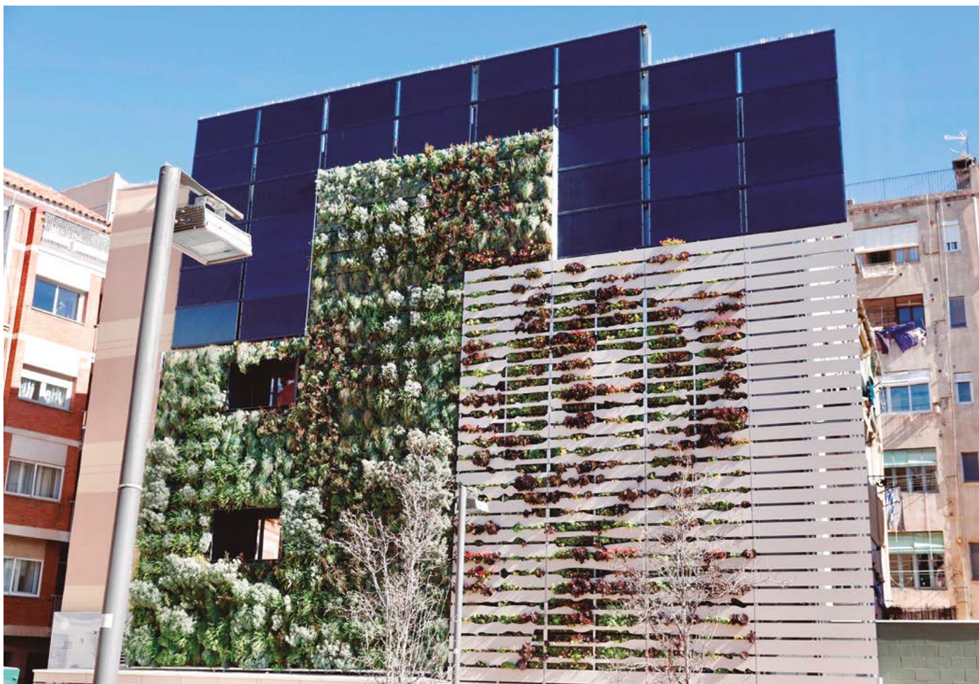
Plaça de les Dones del 36, jardí vertical de gabions de substrat amb utilització de planta C4 i CAM, adaptacions per millorar la resiliència. Foto: www.babilon.cat .
