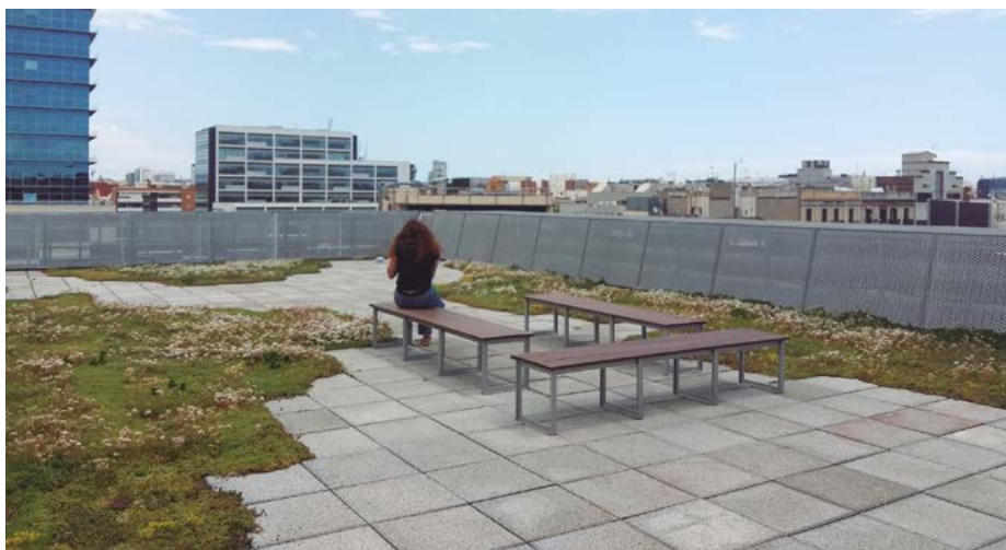
Coberta vegetal extensiva al 22@ de Barcelona. Foto: Toni Arnich.
