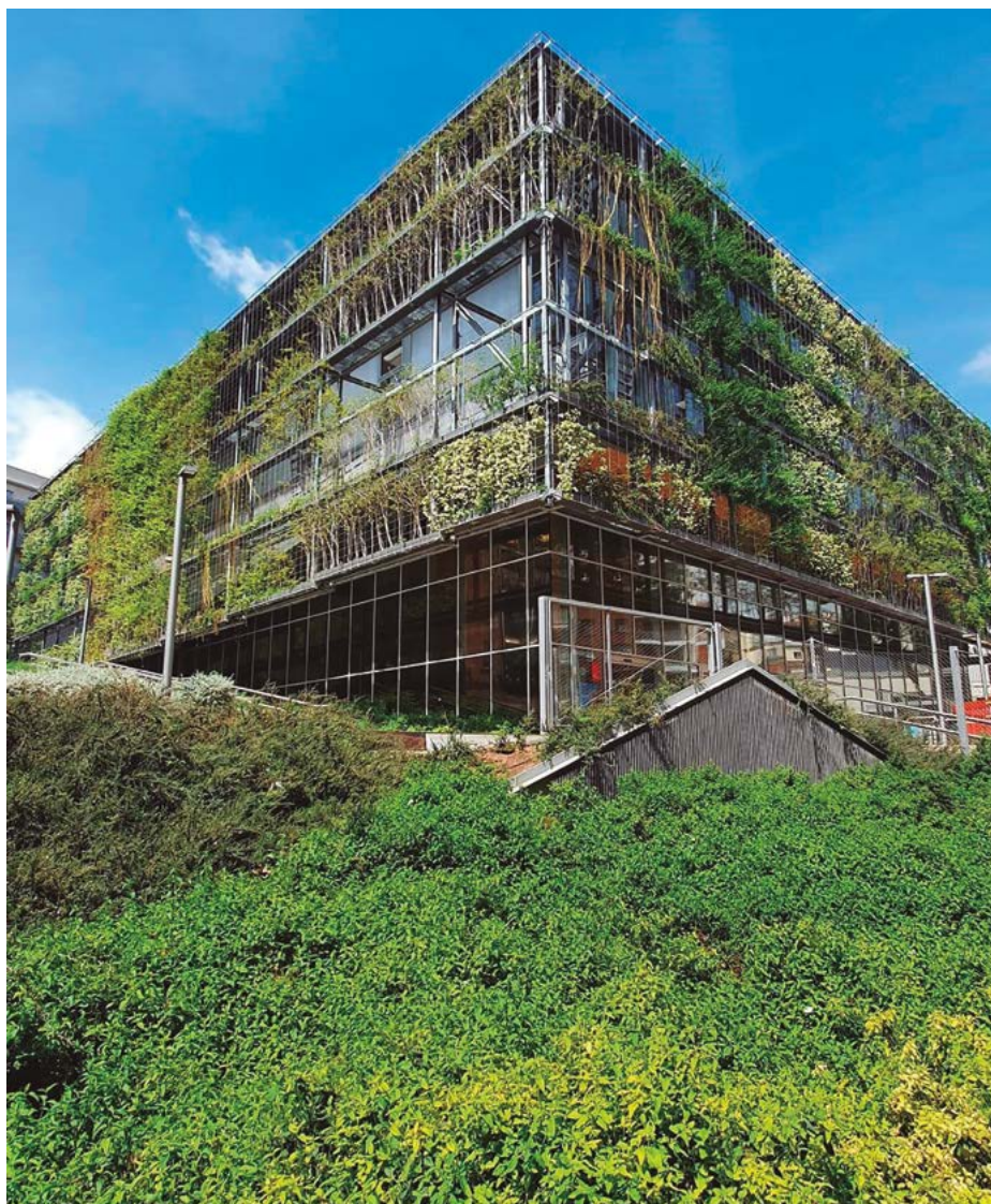
Poliesportiu Turó de la Peira, aplicació d'hidroponia a façana de gran format. Foto: www.babilon.cat .
