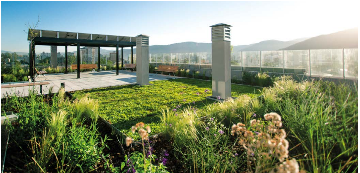
Coberta verda multifuncional. Foto: ZinCo Cubiertas Ecológicas.
