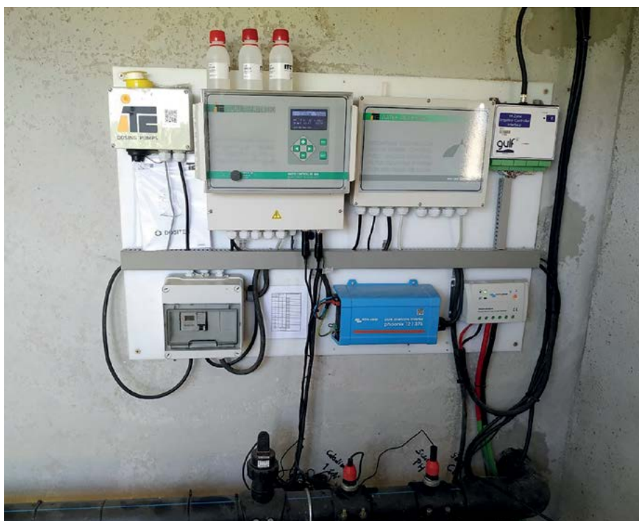
Capçal de reg amb el programador, els sensors de cabal, pH i conductivitat. Foto: IRTA.
